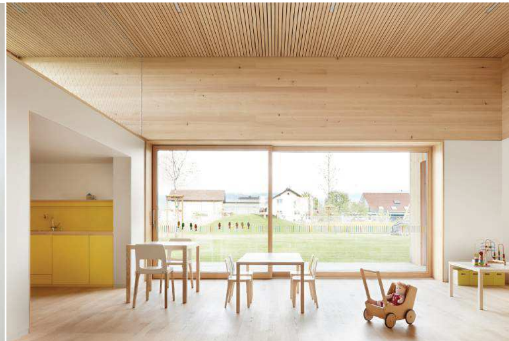
V TRIEDACH JE NA STROPE AKUSTICKÝ PODHLAD
